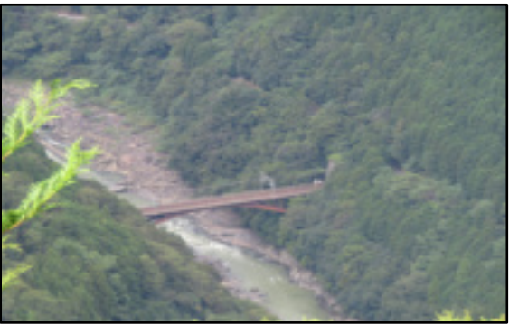
保津川「S字峡」の山陰線の鉄橋とトンネル
