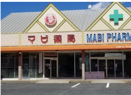
〈写真⑨〉外観は無事だが、浸水し内部は使える状態ではないため、営業されていない薬局。いくつもの店舗が同様の状態だった。
