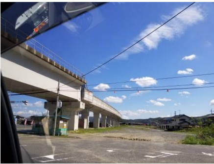
写真② 高架橋まで水位が上がった。
